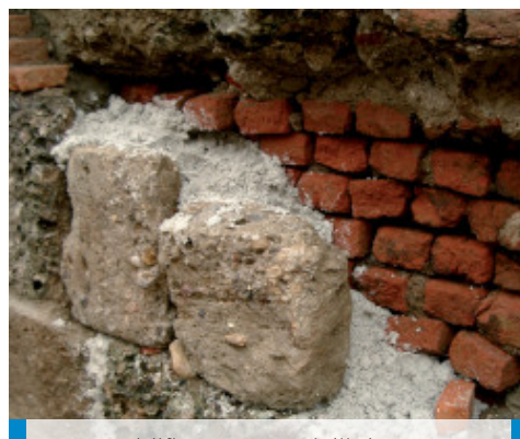
Dezumidificarea tencuielii de tencuiala refacerea unui perete folosind mortar pe santier
