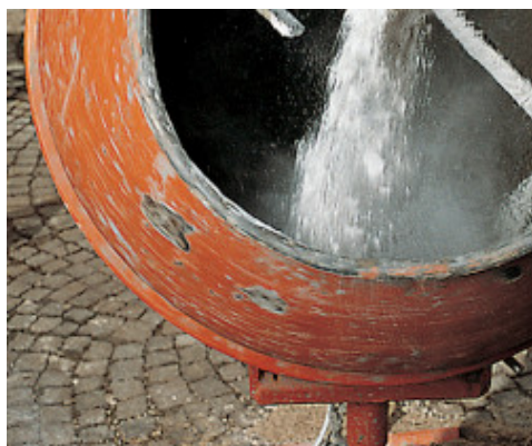
Amestecarea mortarului in situ cu agregate de provenienta locala
