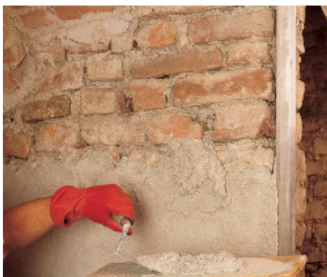
Aplicarea de tencuiala de dezumidificare amestecata in situ
