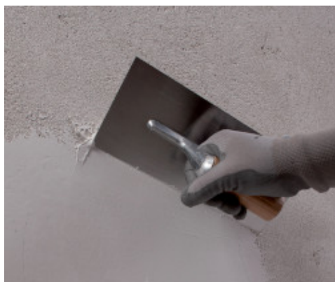
Intindeti un prim strat de Mape-Antique FC Ultrafine
