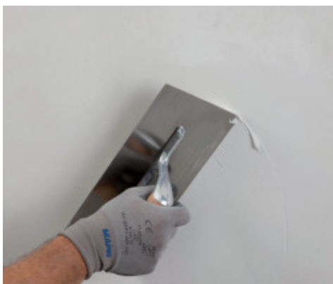
Parte a ciclului de aplicare pentru Mape-Antique FC Ultrafine
