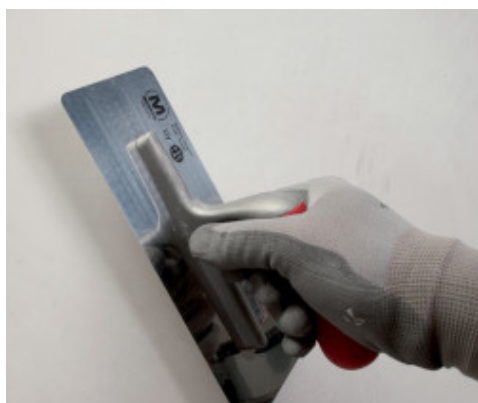
Intindeti un al doilea strat de Mape-Antique FC Ultrafine
