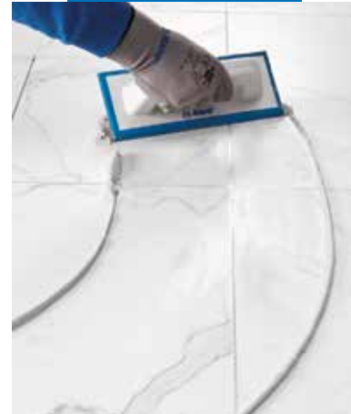
Intinderea chitului Ultracolor Plus cu spatula cauciucata pe o pardoseala din marmura cu efect de portelan
