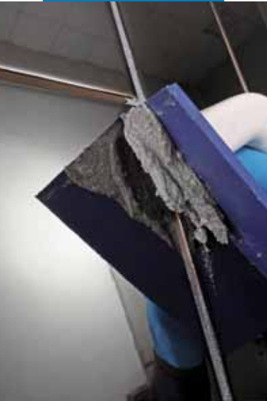
Chituirea rosturilor cu Kerapoxy Design și MapeGlitter Silver (argintiu)
