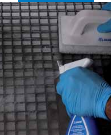
Pulverizare Kerapoxy Cleaner pe suprafața care trebuie curățată
