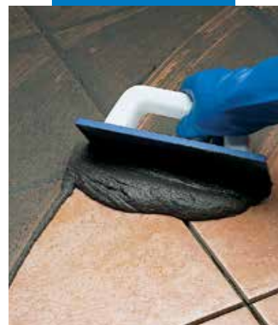
Chituirea plăcilor de gresie cu spatula de cauciuc
