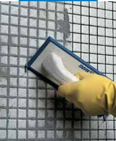
Chituirea mozaicului de sticlă cu spatula de cauciuc
