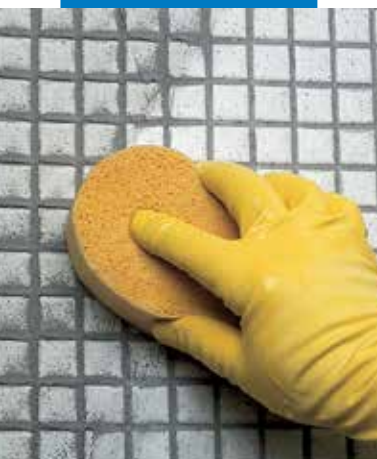
Finisarea chitului de rosturi aplicat pe mozaic de sticlă cu un burete dur din celuloză
