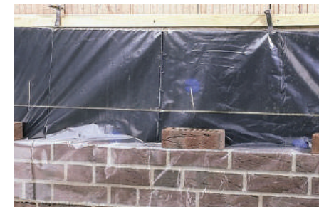
Protecție după montaj
